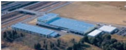
千葉ニュータウン工場 (千葉県印西市) 敷地面積:約8ha 延床面積:19,865.99㎡
